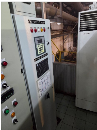
รูปที่ 5 มิเตอร์ไฟฟ้า ตรวจสอบการทำงานของเครื่องดักฝุ่นแบบไฟฟ้าสถิต (ESP)
