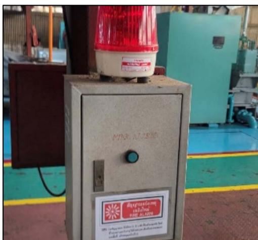
รูปที่ 60 อุปกรณ์ป้องกัน และระบบอัคคีภัย/ระบบสัญญาณแจ้งเหตุเพลิงไหม้
