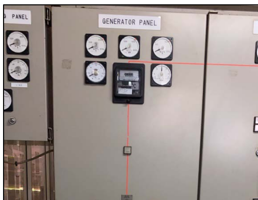
รูปที่ 82 อุปกรณ์ตรวจวัด ป้องกันกระแสเกินขนาดพิกัดกระแสไฟฟ้า
