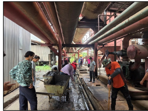
รูปที่ 50 การขุดลอกรางระบายภายในพื้นที่โครงการ
