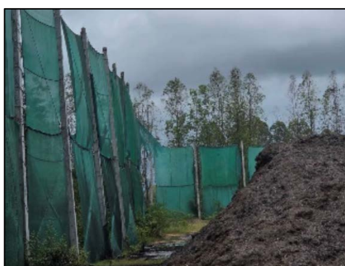
รูปที่ 13 ตาข่ายชะลอลมและดักฝุ่นรอบบริเวณลานกองเก็บขานอ้อย
