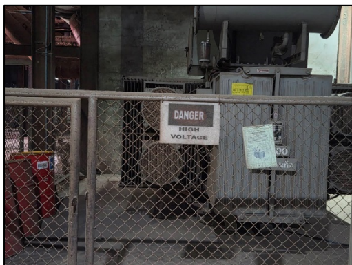
รูปที่ 86 ป้ายแสดงสถานะ และเตือนอันตรายหม้อแปลงไฟฟ้า
