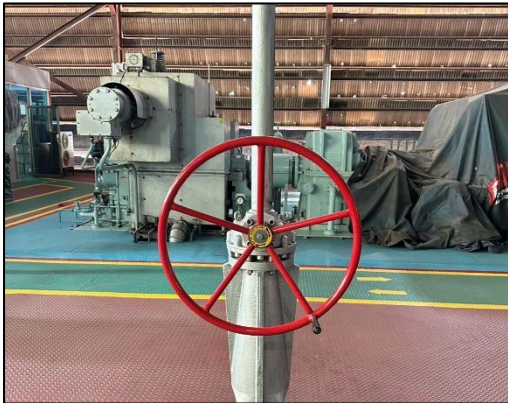
รูปที่ 80 ติดตั้งลิ้นนิรภัย และวาล์วควบคุม (Control Valve)
