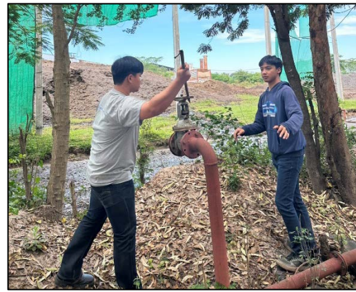
รูปที่ 91 Hydrant และสายฉีดน้ำดับเพลิงรอบลานกองขาน้อย
