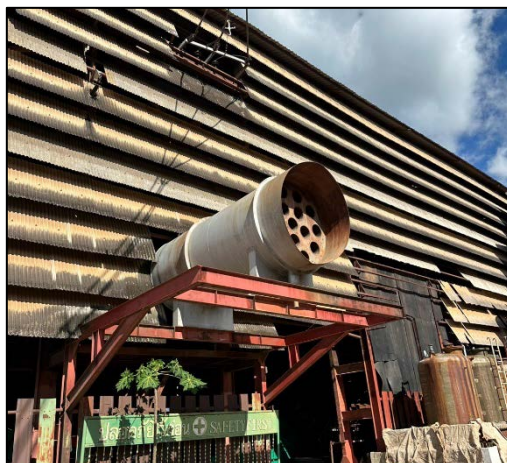
รูปที่ 27 อุปกรณ์ลดเสียง (Silencer) บริเวณที่มีเสียงดัง
