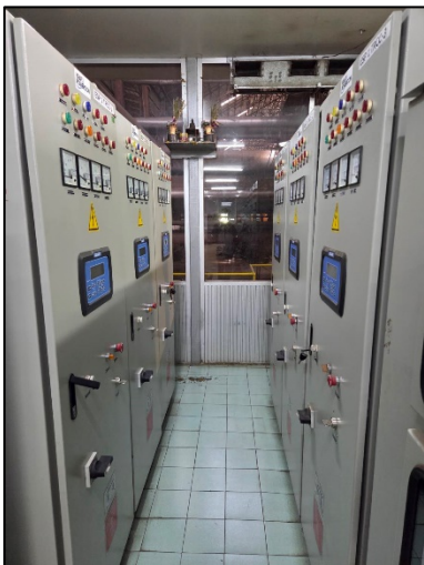
รูปที่ 4 อุปกรณ์ตรวจวัดกระแสไฟฟ้า ของเครื่องดักฝุ่นแบบไฟฟ้าสถิต (ESP)
