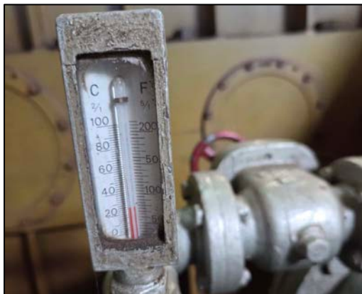
รูปที่ 78 อุปกรณ์ตรวจวัดต่างๆ เพื่อตรวจสอบการทำงานของหน่วยผลิตไอน้ำ
