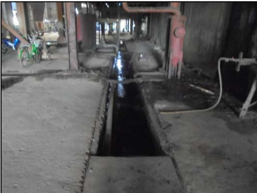
รูปที่ 48 รางระบายน้ำฝนที่ไม่มีโอกาสปนเปื้อน
