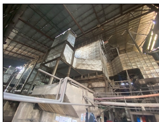
รูปที่ 3 เครื่องดักจับอนุภาคด้วยไฟฟ้าสถิต (Electrostatic Precipitator หรือ ESP)
