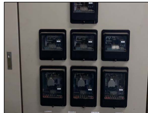
รูปที่ 82 อุปกรณ์ตรวจวัด ป้องกันกระแสเกินขนาดพิกัดกระแสไฟฟ้า
