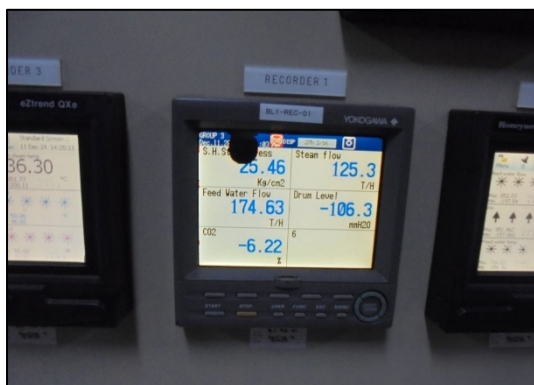
รูปที่ 79 ตรวจวัดอุณหภูมิและความดันทั้งขาเข้า-ขาออกจากกังหันไอน้ำ
