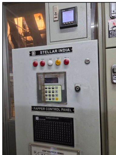
รูปที่ 5 มิเตอร์ไฟฟ้า ตรวจสอบการทำงานของเครื่องดักฝุ่นแบบไฟฟ้าสถิต (ESP)
