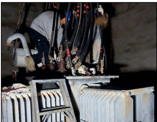
รูปที่ 85 ตรวจสอบบำรุงรักษาหม้อแปลงไฟฟ้า
