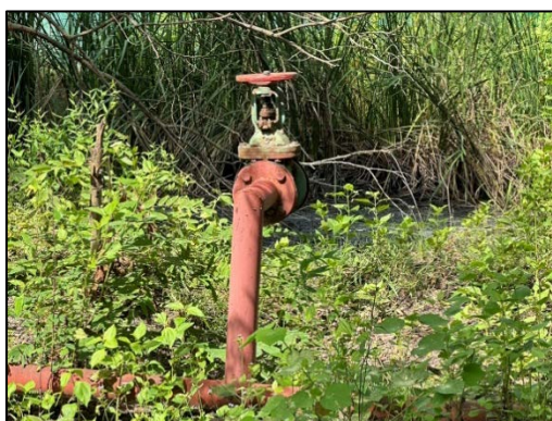
รูปที่ 11 ระบบหัวฉีดน้ำ (Hydrant) บริเวณรอบกองขานอ้อย
