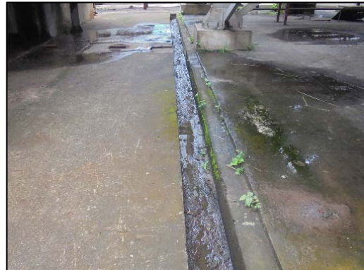
รูปที่ 48 รางระบายน้ำฝนที่ไม่มีโอกาสปนเปื้อน
