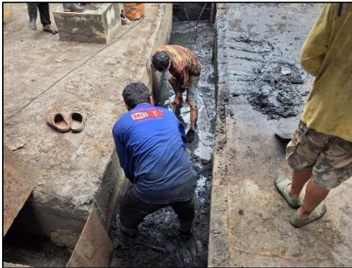
รูปที่ 50 การขุดลอกรางระบายภายในพื้นที่โครงการ
