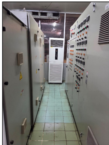
รูปที่ 4 อุปกรณ์ตรวจวัดกระแสไฟฟ้า ของเครื่องดักฝุ่นแบบไฟฟ้าสถิต (ESP)
