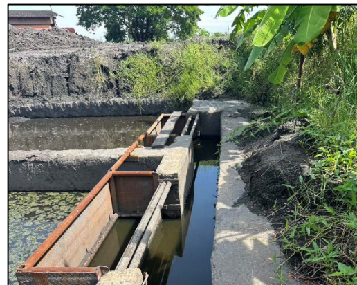
รูปที่ 39 ระบบรวบรวมน้ำเสียที่เกิดจากการฟื้นฟูระบบผลิตน้ำอ่อน
