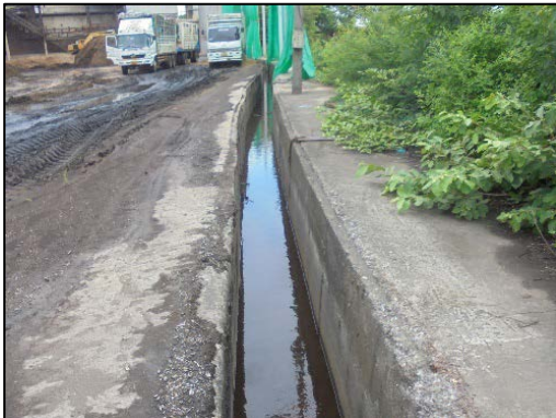
รูปที่ 37 ระบบระบายน้ำเสียของโครงการ
