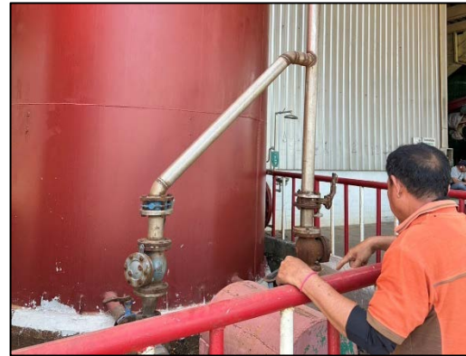
รูปที่ 76 ตรวจสอบข้อต่อ วาล์ว ป้อน และถังเก็บสารเคมี
