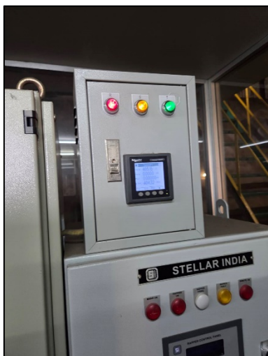
รูปที่ 4 อุปกรณ์ตรวจวัดกระแสไฟฟ้า ของเครื่องดักฝุ่นแบบไฟฟ้าสถิต (ESP)
