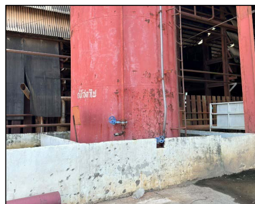
รูปที่ 77 ถังคอนกรีตรอบบริเวณถังเก็บกากสารเคมีของเหลว
