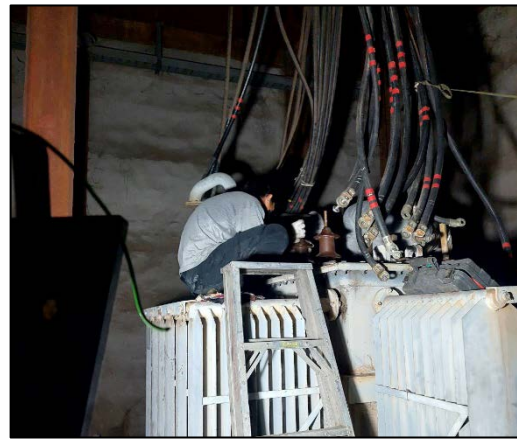
รูปที่ 85 (ต่อ) ตรวจสอบบำรุงรักษาหม้อแปลงไฟฟ้า
