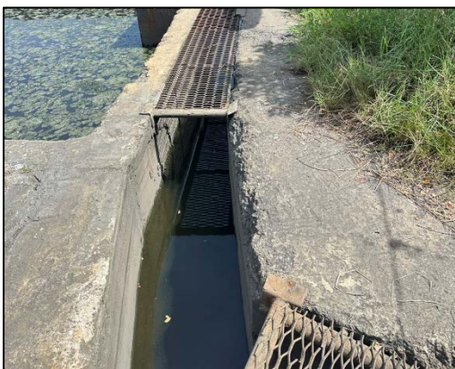
รูปที่ 39 ระบบรวบรวมน้ำเสียที่เกิดจากการฟื้นฟูระบบผลิตน้ำอ่อน
