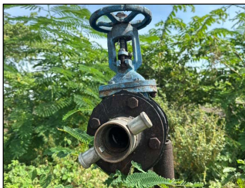
รูปที่ 11 ระบบหัวฉีดน้ำ (Hydrant) บริเวณรอบกองขานอ้อย
