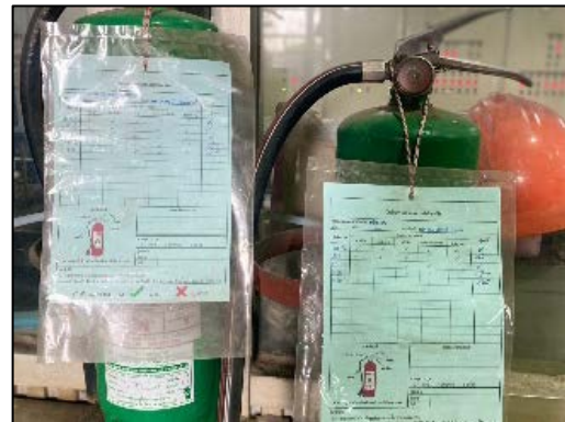
รูปที่ 61 การตรวจสอบอุปกรณ์ป้องกันและระงับอัคคีภัย
