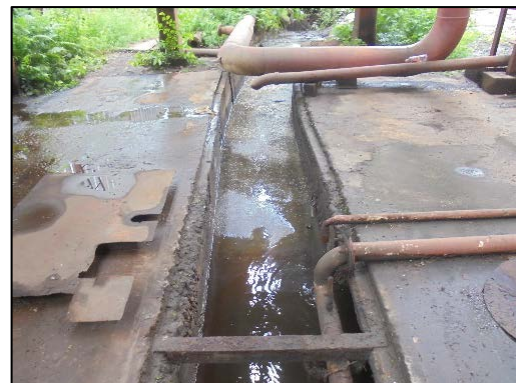
รูปที่ 38 ระบบระบายน้ำฝนปนเปื้อน
